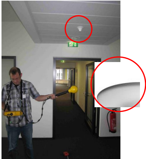
Kleinzelle indoor (Pikozelle) Einige 10 m Abdeckung Rundstrahlend oder gerichtet Antennendiagramm statisch
