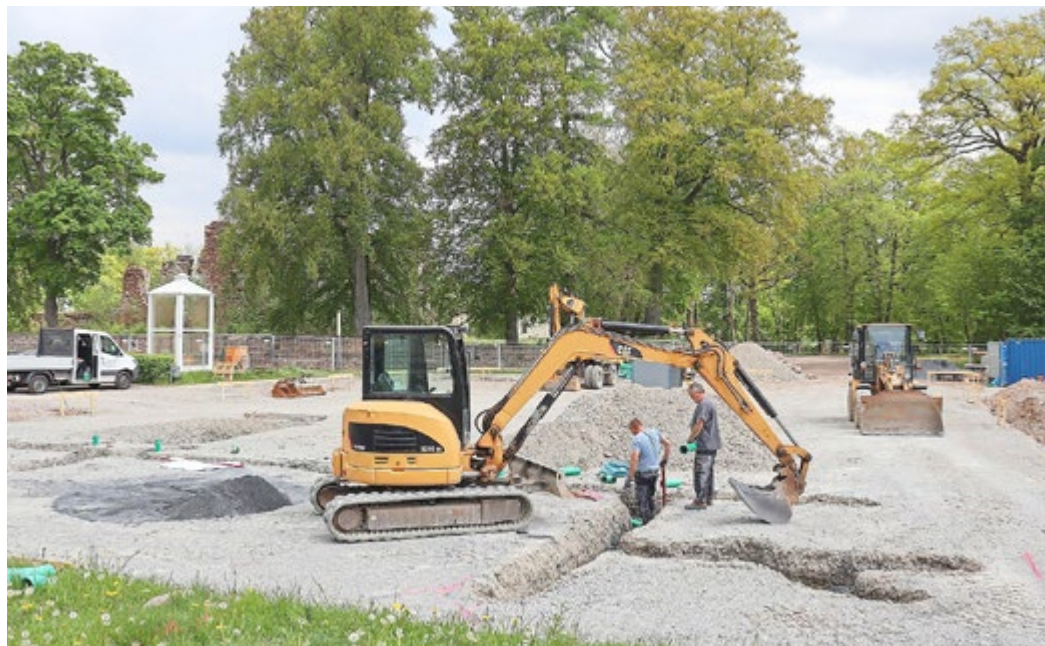
Für den neuen Kindergarten im Ortsteil Stadt Gehren wurden bereits die ersten Gründungsarbeiten vorgenommen.
