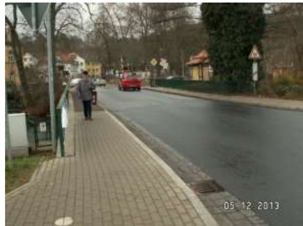
Abbildung 14 Brücke in der Waldstraße
