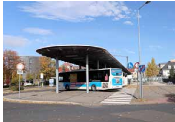
Abb. 64 Busbahnhof Ilmenau (Kernstadt)
