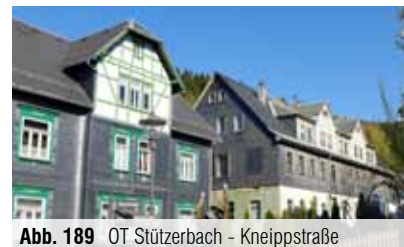
Abb. 189 OT Stützerbach - Kneippstraße
