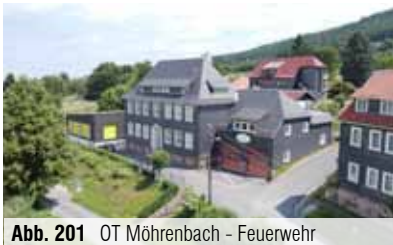
Abb. 201 OT Möhrenbach - Feuerwehr
