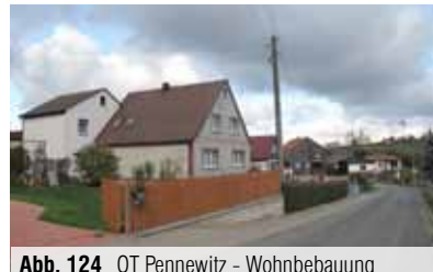
Abb. 124 OT Pennewitz - Wohnbebauung
