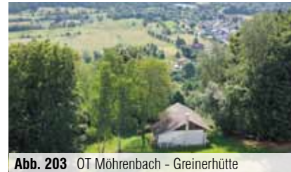
Abb. 203 OT Möhrenbach - Greinerhütte
